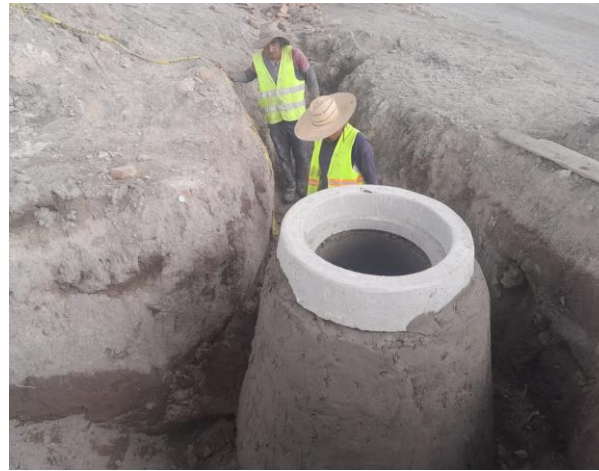
APLANADO EXTERIOR DE POZO DE VISITA
