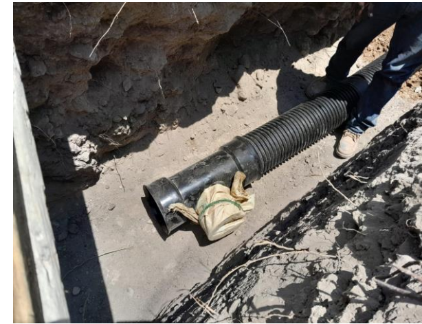
INSTALACIÓN DE TEEWEY PARA DESCARGAS DOMICILIARIAS
