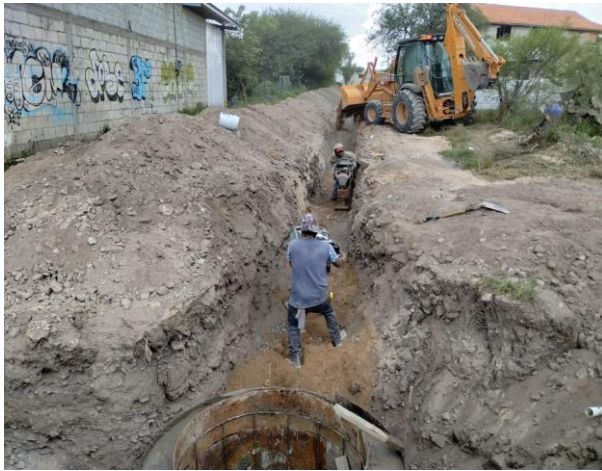
COMPACTACIÓN ACOSTILLAMIENTO DE TUBERÍA
