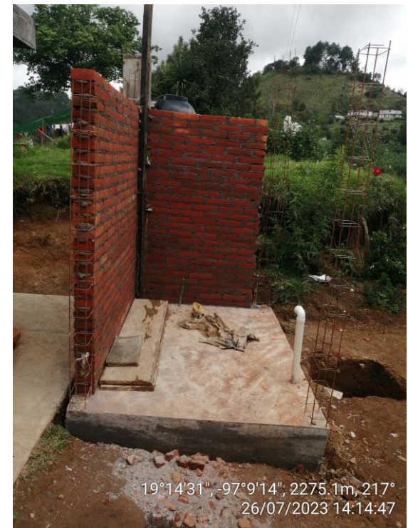
-Construcción de muros y losa de piso
