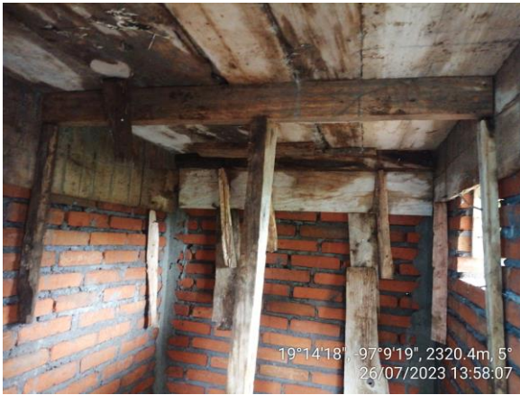
-Cimbra en losa superior
