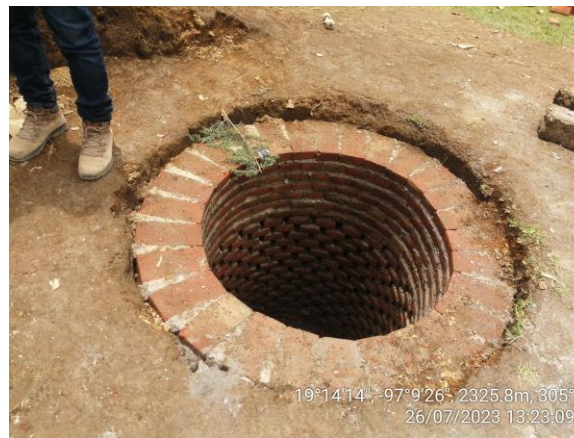
-Construcción de pozo de absorción.
