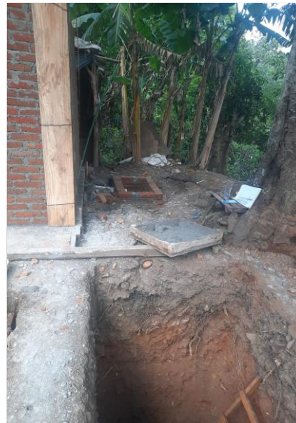
EXCAVACIÓN PARA LA CONSTRUCCIÓN DEL REGISTRO DEL BIODIGESTOR Y REGISTRO SANITARIO
