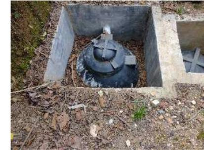
**ETAPA DEL PROCESO DE LA OBRA CON LA CONSTRUCCIÓN DE LA CASETA DE BAÑO A NIVEL DE REPELLADO, INSTALACIÓN DE BIODIGESTOR, DEPOSITO DE LODOS CON SUS RESPECTIVOS REGISTROS DE INSPECCIÓN, INSTALACIÓN DE TINACO E INSTALACIÓN HIDRÁULICA CON TUBERÍA DE CPVC DE ½” DE DIÁMETRO**
