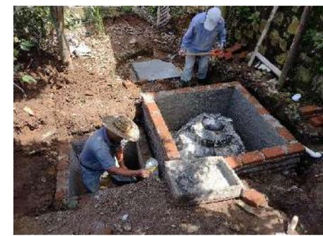
**ETAPA DE INICIO DE OBRA CON ACTIVIDADES DE LIMPIEZA, TRAZO Y EXCAVACIÓN PARA LA INSTALACIÓN DE EQUIPOS DE SANEAMIENTO Y CONSTRUCCIÓN DE POZO DE ABSORCIÓN**
