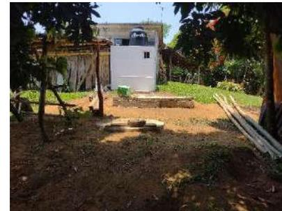
**ETAPA DE OBRA TERMINADA DEL SISTEMA DE SANEAMIENTO, QUE COMPRENDE ENTRE OTROS, LOS REGISTROS DE INSPECCIÓN DEL DEPOSITO DE LODOS, BIODIGESTOR Y POZO DE ABSORCIÓN, CON SUS TAPAS DE CONCRETO, PLACA DE IDENTIFICACIÓN E INSTALACIÓN DE TINACO DE 450 LITROS DE CAPACIDAD, INSTALACIÓN HIDRÁULICA**
