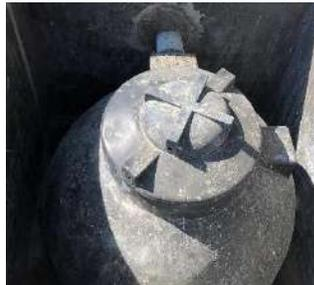
INSTALACIÓN DE BIODIGESTOR DE POLIETILENO CON CAPACIDAD DE 600 LTS
