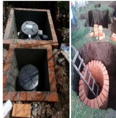
LIMPIA, TRAZO Y EXCAVACIÓN DE REGISTRO DE BIODIGESTOR, LODOS Y POZO DE ABSORCIÓN
