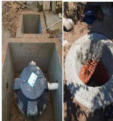
LIMPIA, TRAZO Y EXCAVACIÓN DE REGISTRO DE BIODIGESTOR, LODOS Y POZO DE ABSORCIÓN
