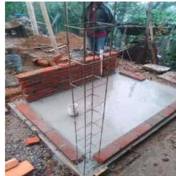
CONSTRUCCIÓN LOSA DE PISO, MURO DE TABIQUE ROJO COMÚN
