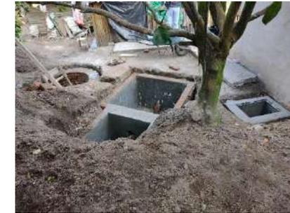
**INICIO DE OBRA CON LA LIMPIEZA, TRAZO Y EXCAVACIÓN DE LAS ÁREAS DESTINADAS A LA INSTALACIÓN DE LOS EQUIPOS DE SANEAMIENTO**
