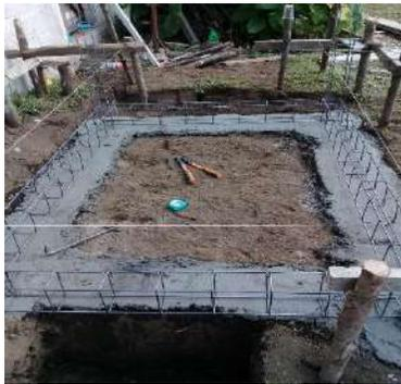
LIMPIA, TRAZO, NIVELACIÓN Y EXCAVACIÓN, PLANTILLA Y COLADO DE DADO CON ARMEX Y COLOCACIÓN DE CADENA
