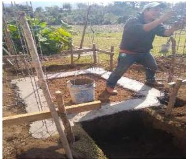
LIMPIA, TRAZO, NIVELACIÓN Y EXCAVACIÓN, PLANTILLA Y COLADO DE DADO CON ARMEX
