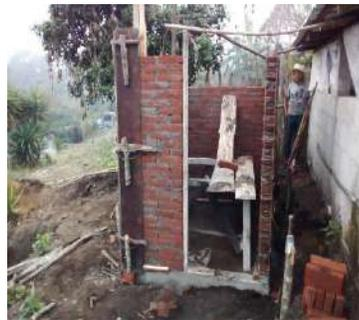
CONSTRUCCIÓN LOSA DE PISO, MURO DE TABIQUE ROJO COMÚN
