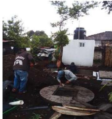
CONSTRUCCIÓN DE CASETA REGISTROS DE L BIODIGESTOR, LODOS Y POZO DE ABSORCIÓN
