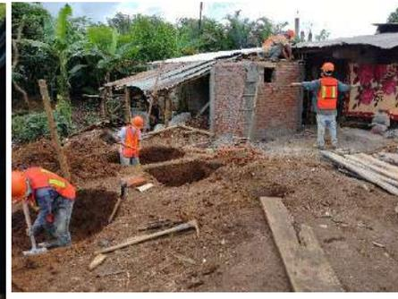
**ETAPA DE INICIO DE OBRA CON ACTIVIDADES DE LIMPIEZA, TRAZO Y EXCAVACIÓN PARA LA INSTALACIÓN DE EQUIPOS DE SANEAMIENTO Y CONSTRUCCIÓN DE POZO DE ABSORCIÓN, COLADO DE LOSA INFERIOR PARA DESPLANTE DE CASETA DE BAÑO**
