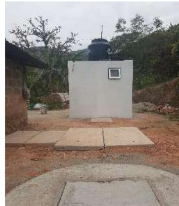
CONSTRUCCIÓN DE CASETA TERMINADA CON REGISTROS DEL BIODIGESTOR, LODOS Y POZO DE ABSORCIÓN CON TAPA
