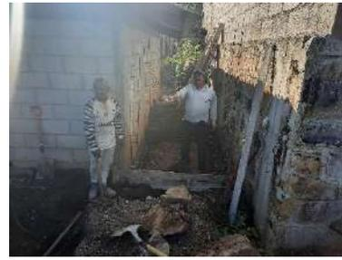
EXCAVACIÓN PARA DESPLANTE DE LOSA DE CIMENTACIÓN
