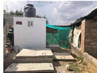
OBRA TERMINADA, SISTEMA DE SANEAMIENTO A BASE DE BIODIGESTOR
