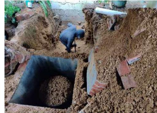
**ACTIVIDADES PROCESO CON EXCAVACIÓN, CONSTRUCCIÓN DE REGISTROS DE INSPECCIÓN Y TAPAS, CONSTRUCCIÓN DE POZO DE ABSORCIÓN**
