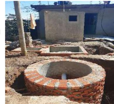
CONSTRUCCIÓN DEL CASETA, REGISTRO DEL BIO, LODOS, POZO DE ABSORCIÓN E INSTALACIONES SANITARIAS.
