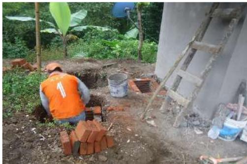
**PROCESO DE LA OBRA CON LAS ACTIVIDADES DE EXCAVACIÓN Y CONSTRUCCIÓN DE REGISTROS DE INSPECCIÓN, INSTALACIÓN DE BIODIGESTOR Y DEPOSITO DE LODOS**
