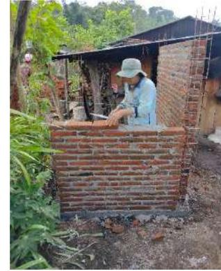
**ACTIVIDADES DE PROCESO DE LA OBRA CON LA CONSTRUCCIÓN DE MUROS DE TABIQUE, INSTALACIONES HIDRÁULICAS Y ELÉCTRICAS**
