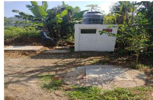
**OBRA TERMINADA CON CASETA DE BAÑO REPELLADO Y PINTADA, POZO DE ABSORCIÓN, BIODIGESTOR, DEPOSITO DE LODOS, REGISTROS DE INSPECCIÓN, TINACO, MUEBLES DE BAÑO**
